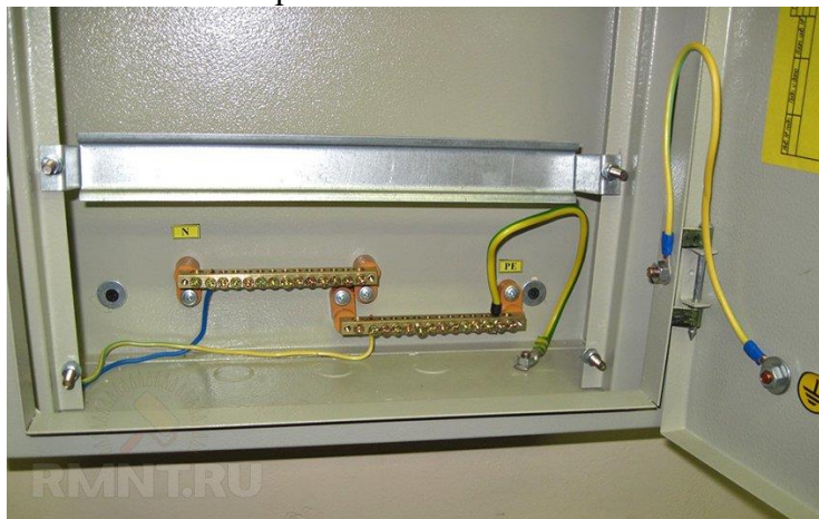
Рис.8. Сборка и предварительный монтаж щита учета.
