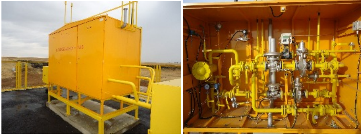
Рисунок 2.3 - Оборудование ГРПШ
